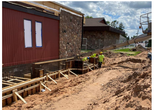
South Firewall Foundations Pour
